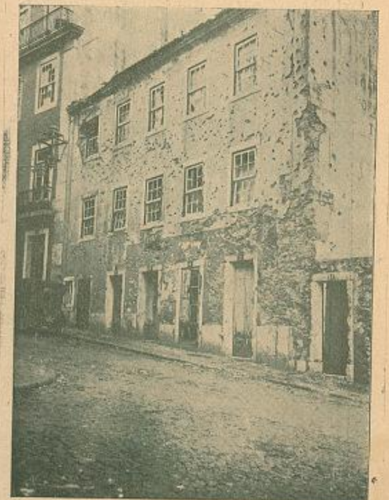
O predio da entrada da Rua de S. Filipe Nery, que conflua com a Praça do Brazil, cravado de metralha revolucionaria.
