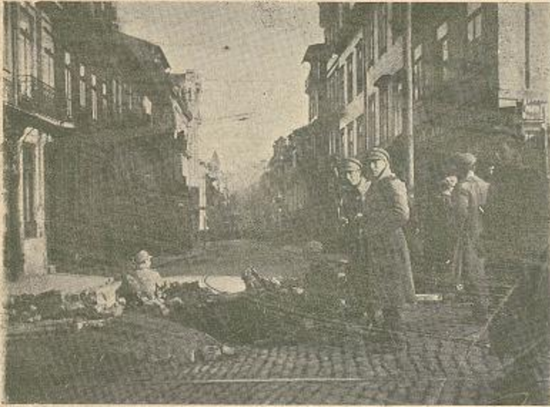
Aspecto da fortíssima trincheira do topo da Rua de Santa Catarina, reducto principal da guerra de vedetas feita nas ruas do Porto.
