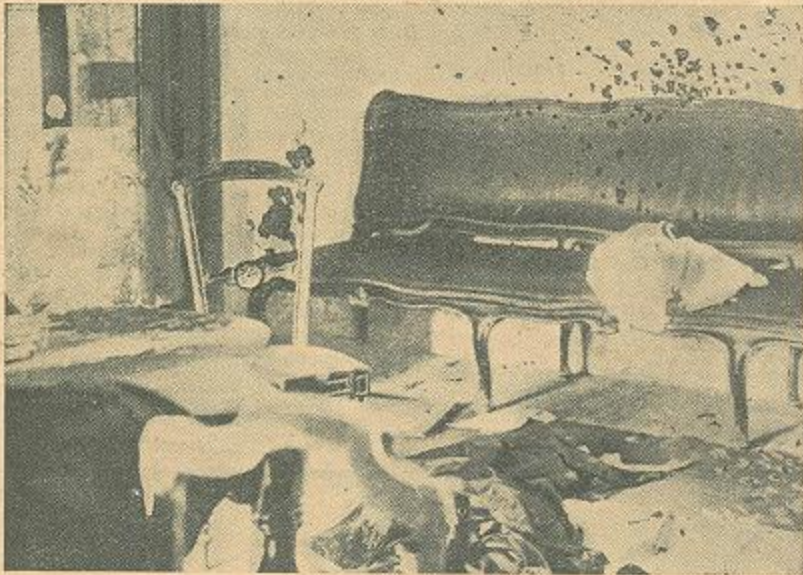
Os destroços causados por uma granada no 5.º andar dum prédio de esquina no alto da rua da Madalena
