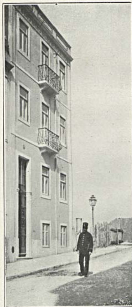
O «hospital de sangue» da rua Leandro Braga, a Campolide Fachada do edificio
