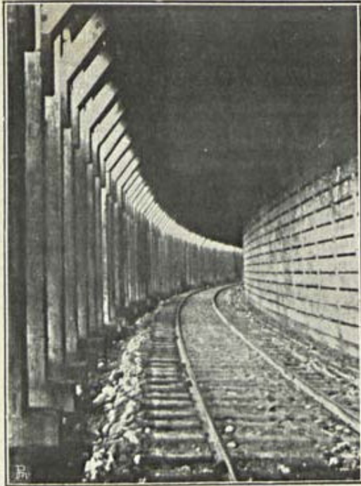
As grandes linhas de caminhos de ferro Abrigo de madeira contra a neve
