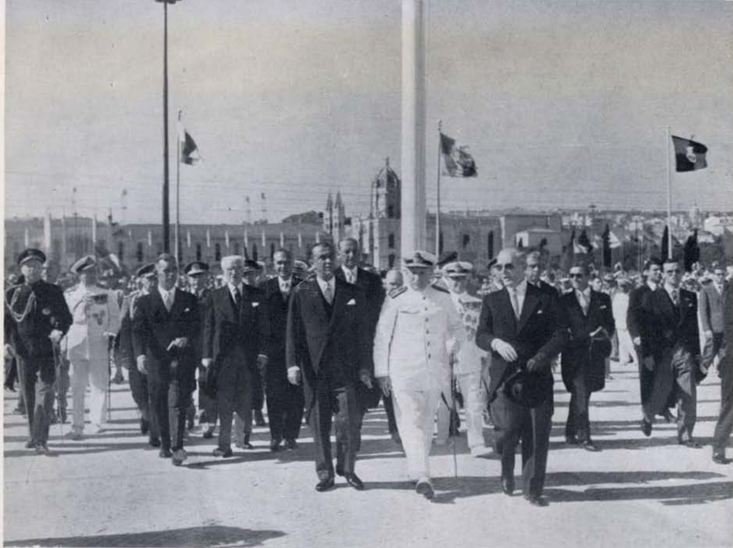
Na inauguração do Monumento das Descobertas, em Belém
