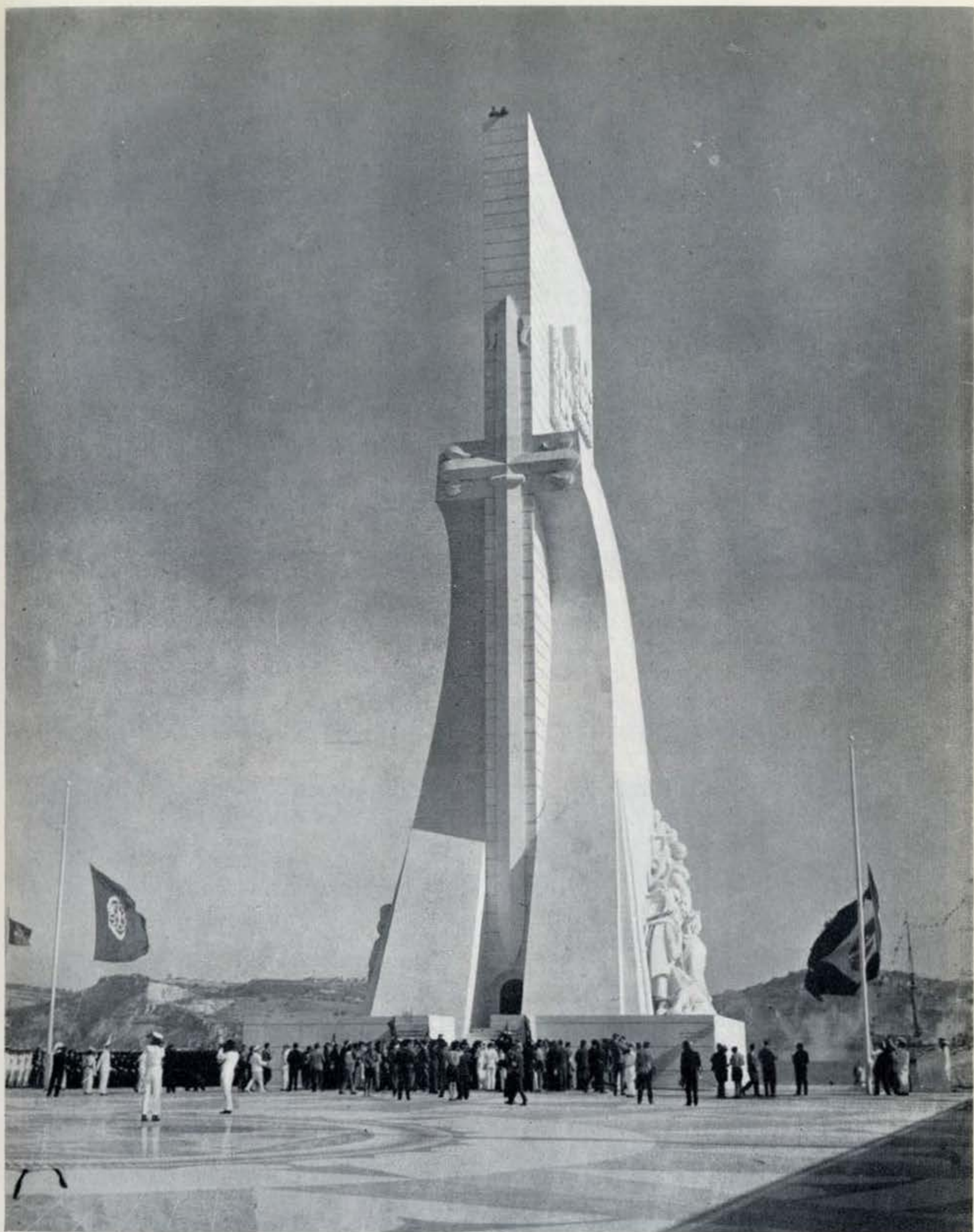
Inauguração do Monumento das Descobertas — Um aspecto do monumento
