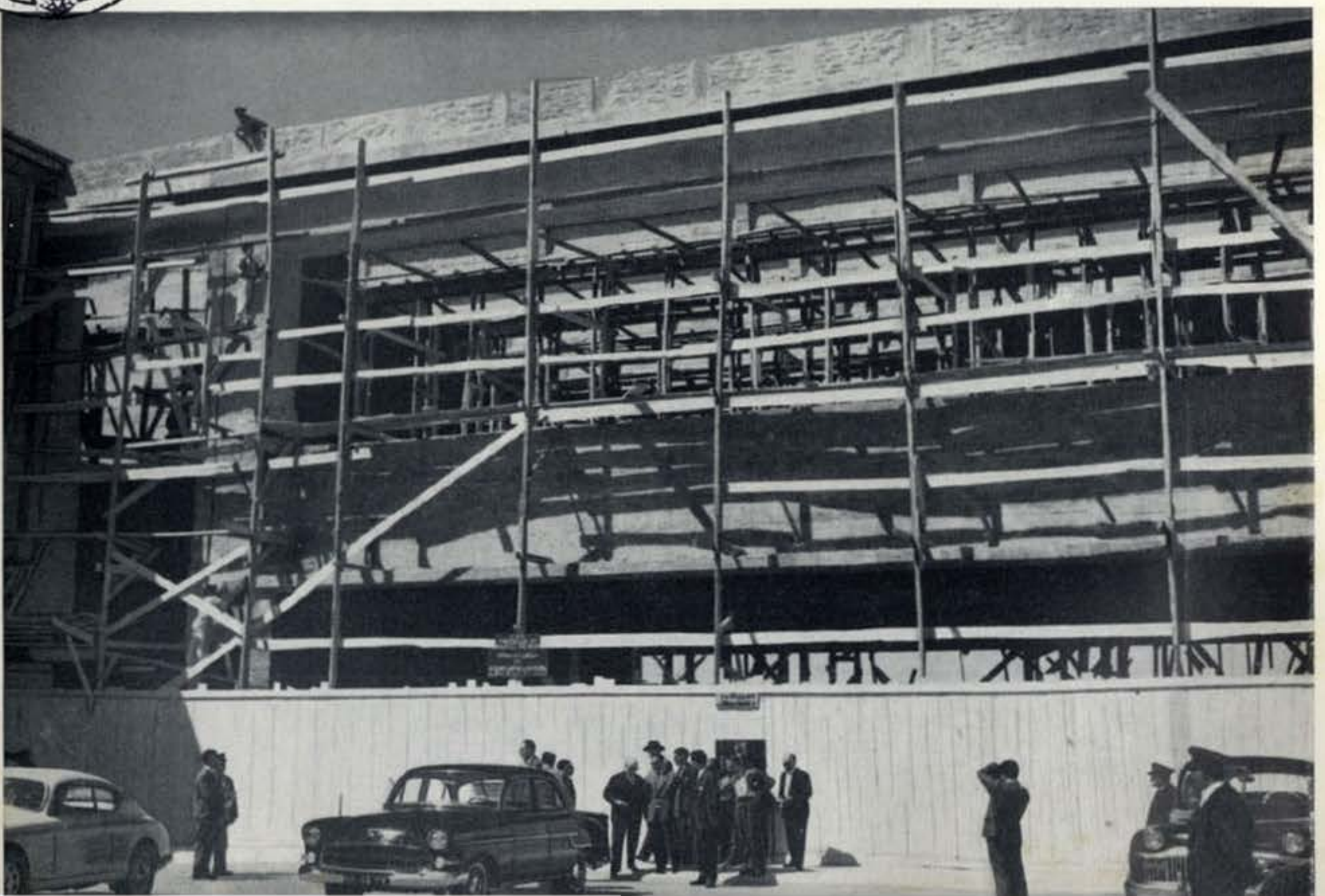
O Presidente e a Vereação visitam as obras no Quartel do B. S. B. em Alvalade
