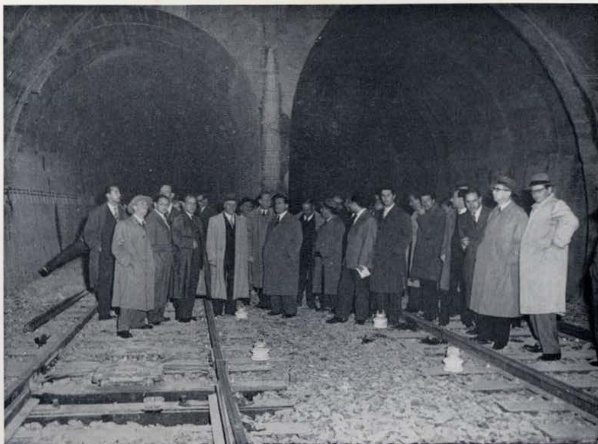
Visita da Presidência e Vereação da Câmara Municipal de Lisboa às obras do Metropolitano
