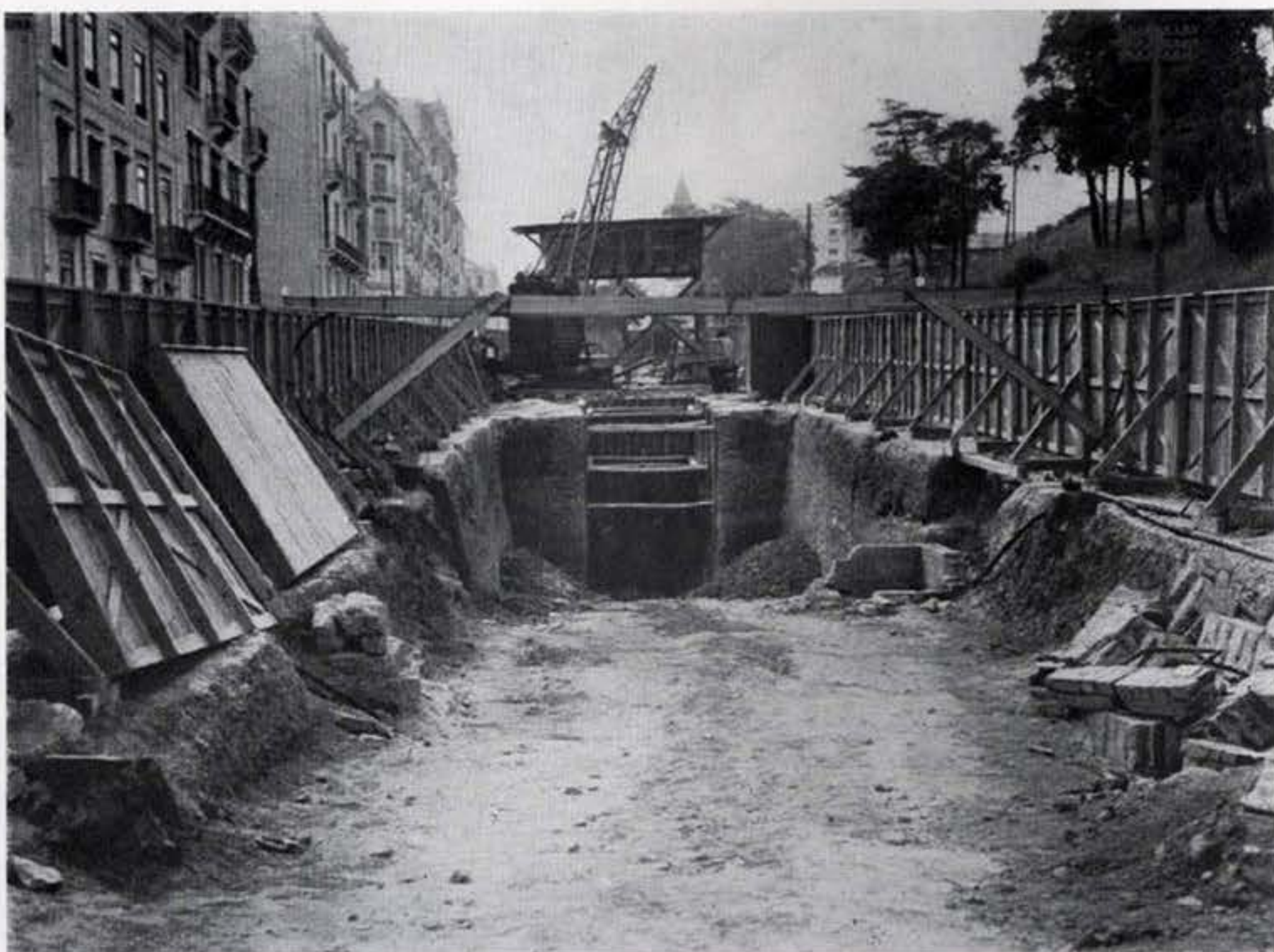
Início das obras do Metropolitano de Lisboa
