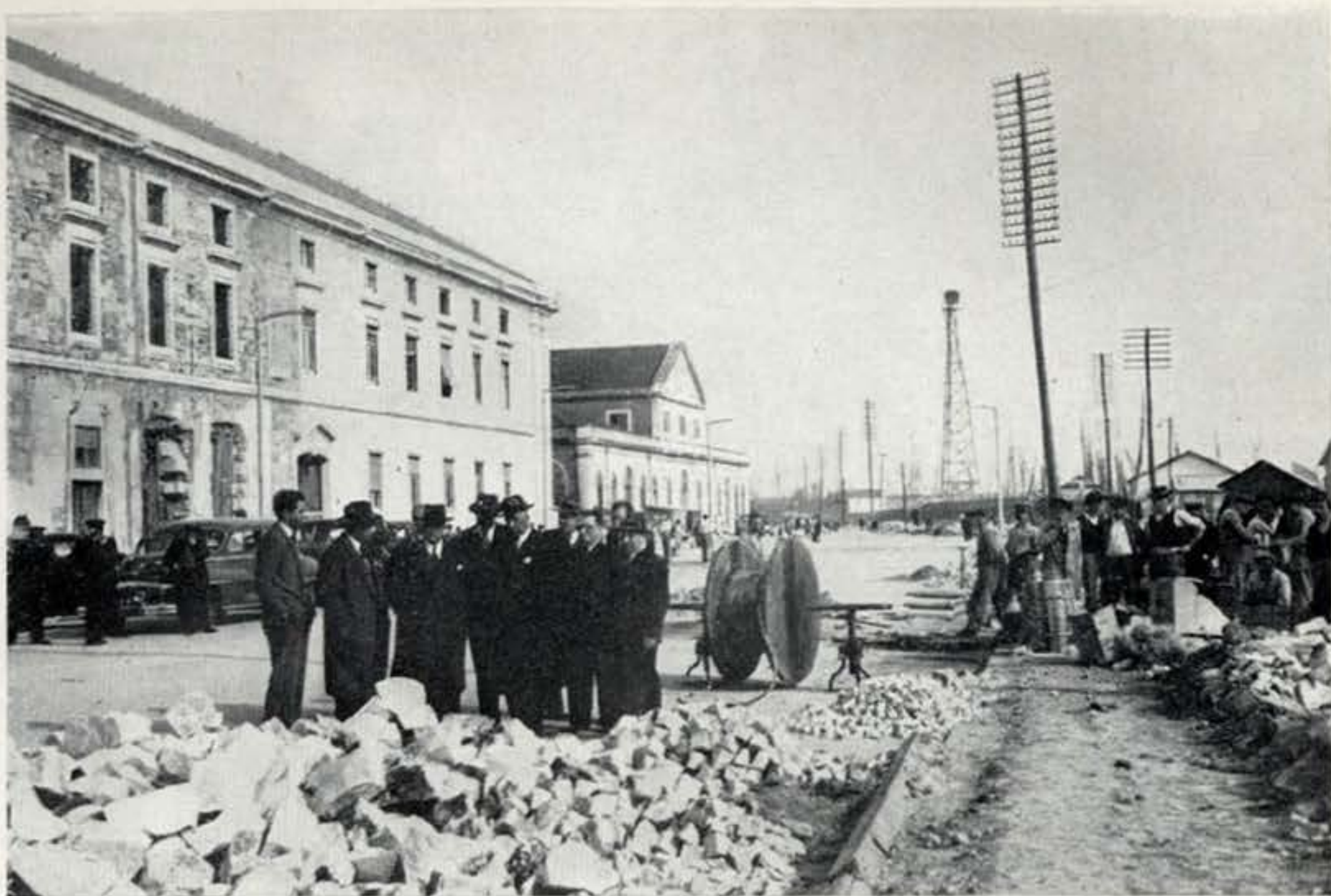
Visita da Vereação às obras da Avenida de Infante D. Henrique
