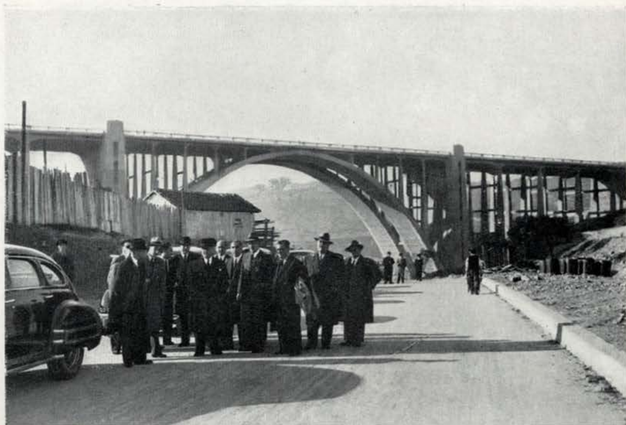
Visita da Vereação às obras da Avenida de Ceuta
