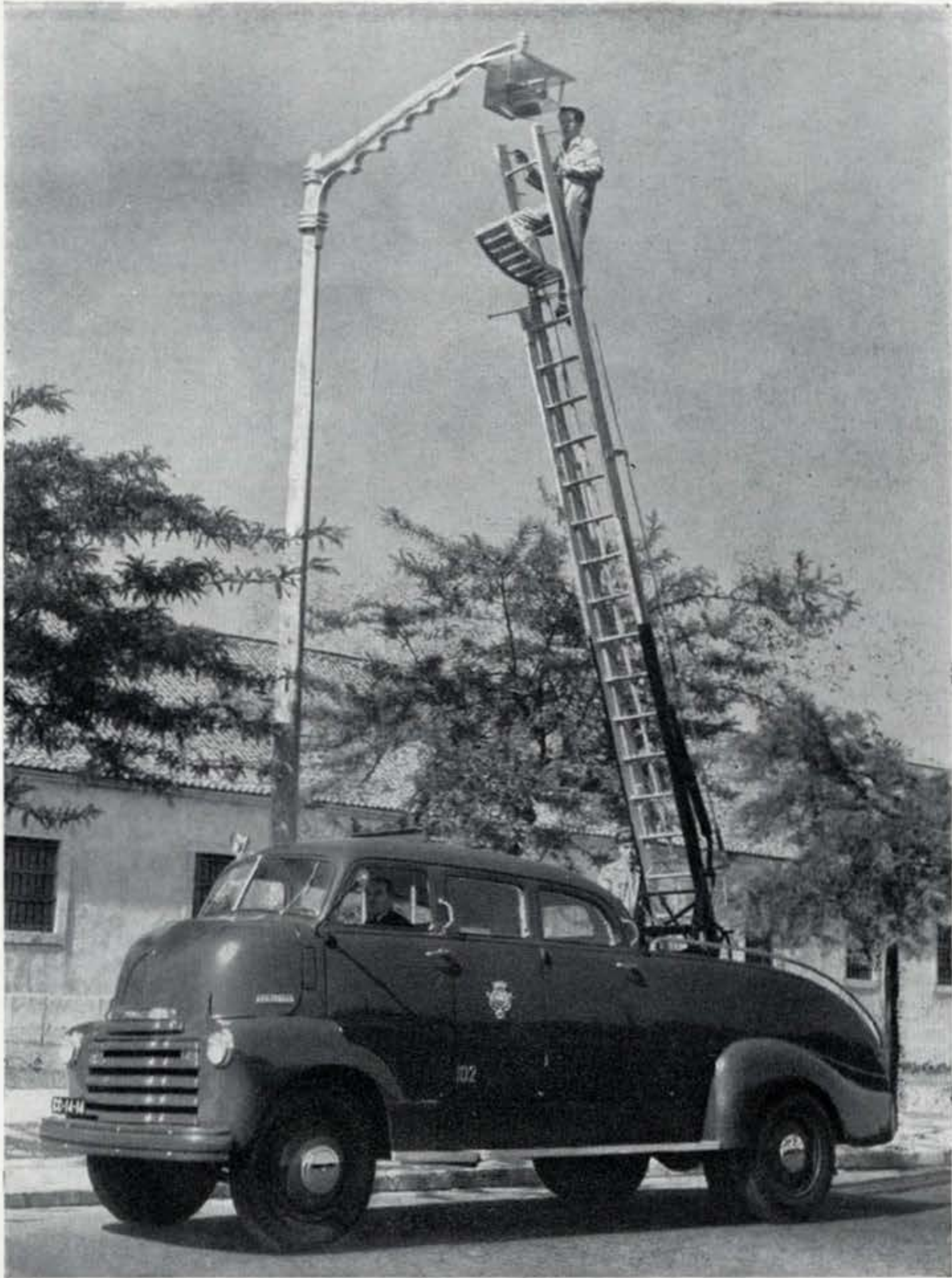
Iluminação Pública — Pronto-socorro
