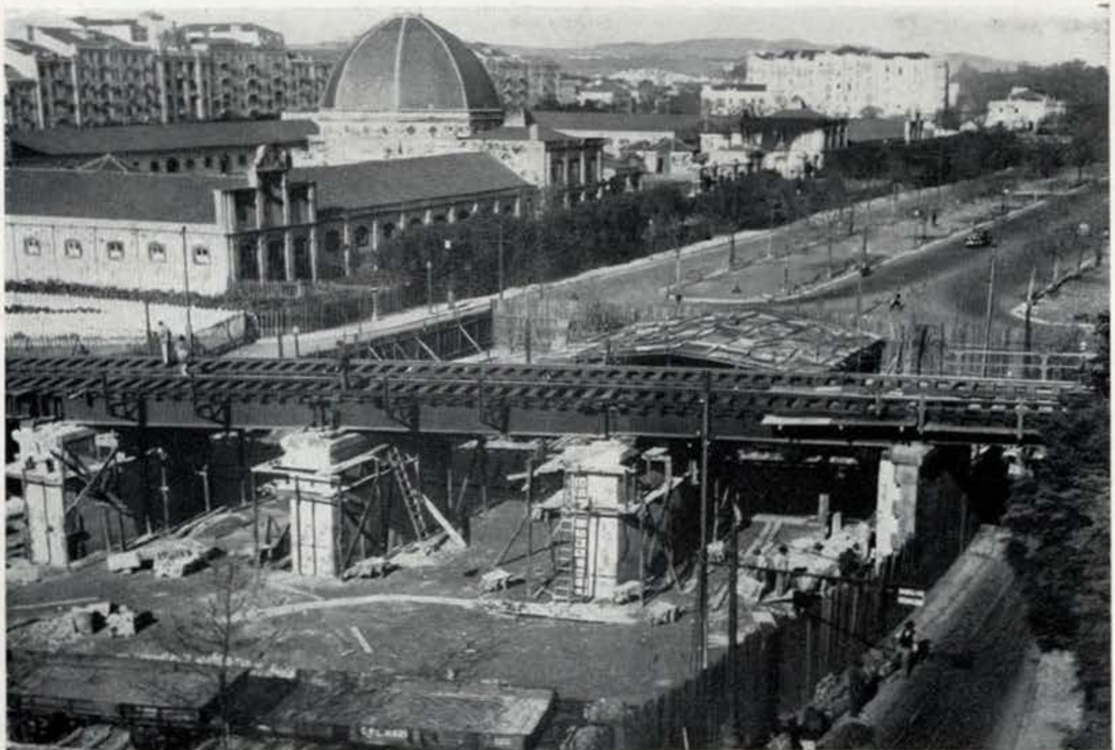
Um aspecto das obras no Viaduto da Avenida da República
