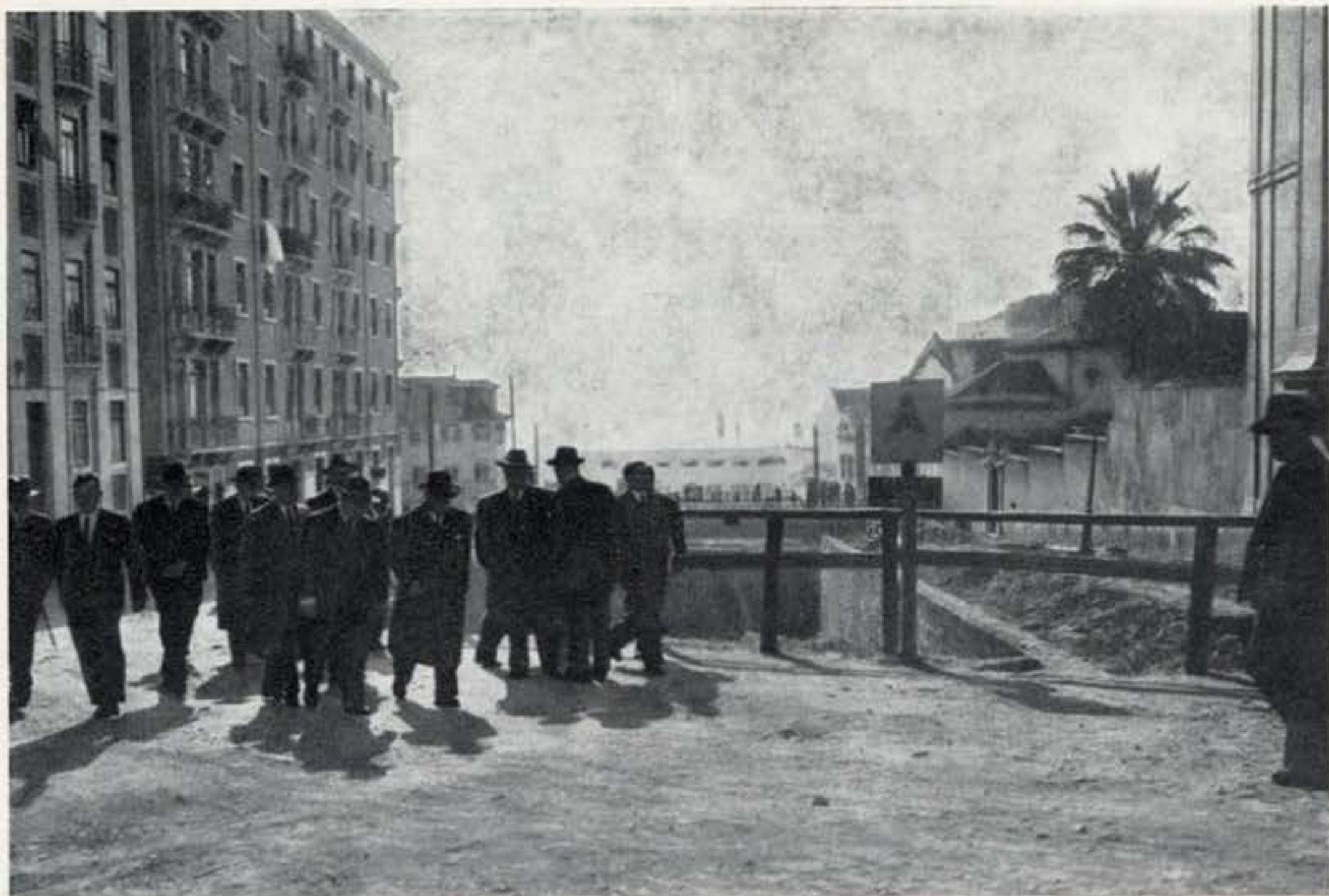
Visita da Vereação às obras da Avenida Tenente Valadim
