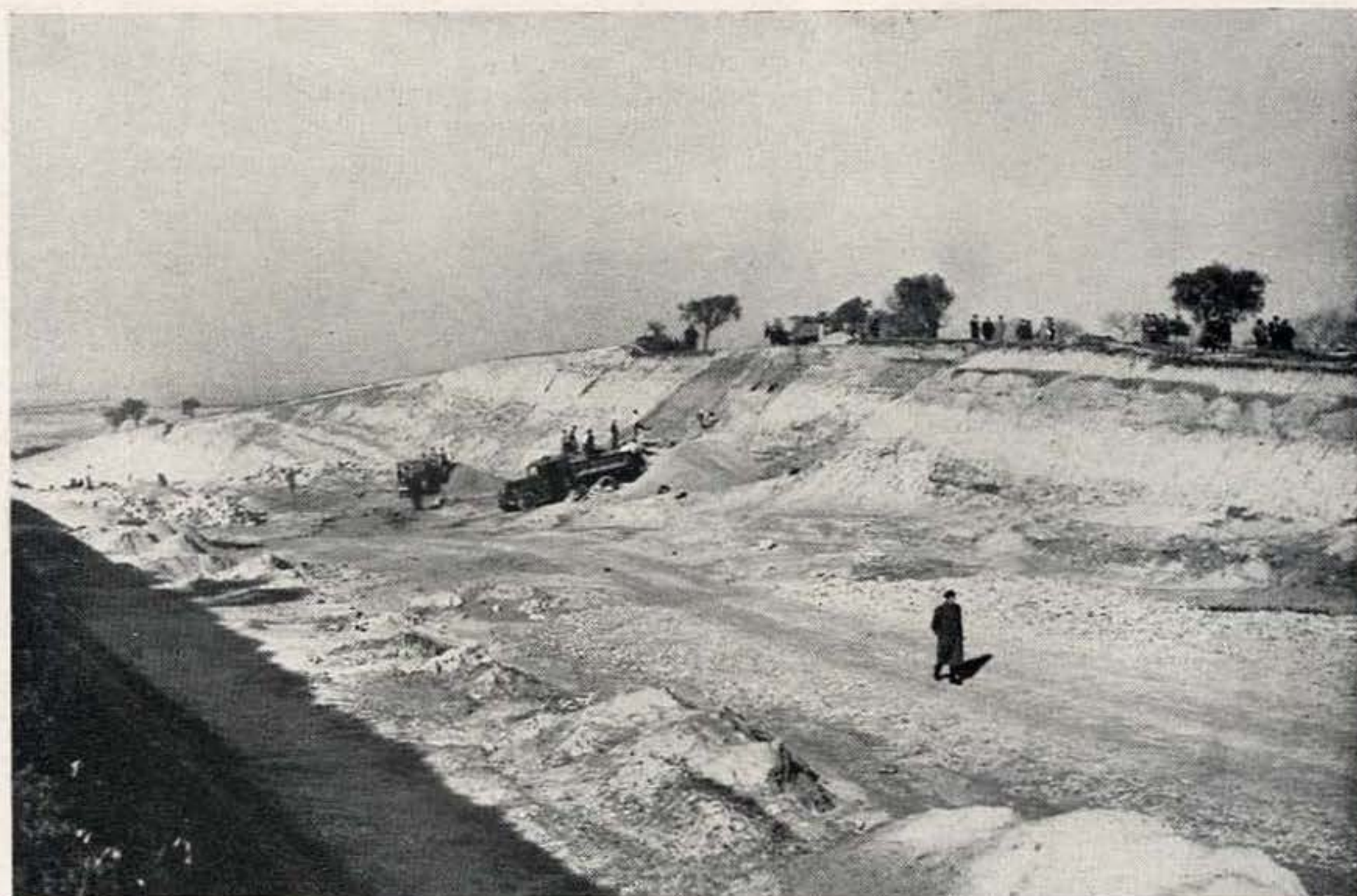
Aspecto das terraplenagens levadas a efeito para a urbanização da zona a sul da Avenida Alferes Malheiro
