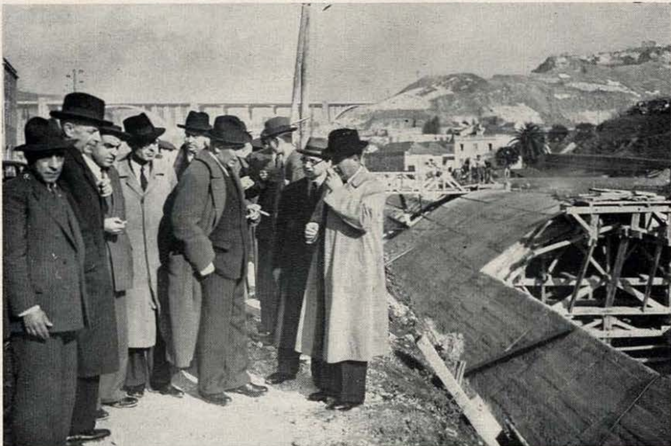
O Presidente da C. M. L., acompanhado da vereação, visita as obras da canalização da ribeira de Alcântara
