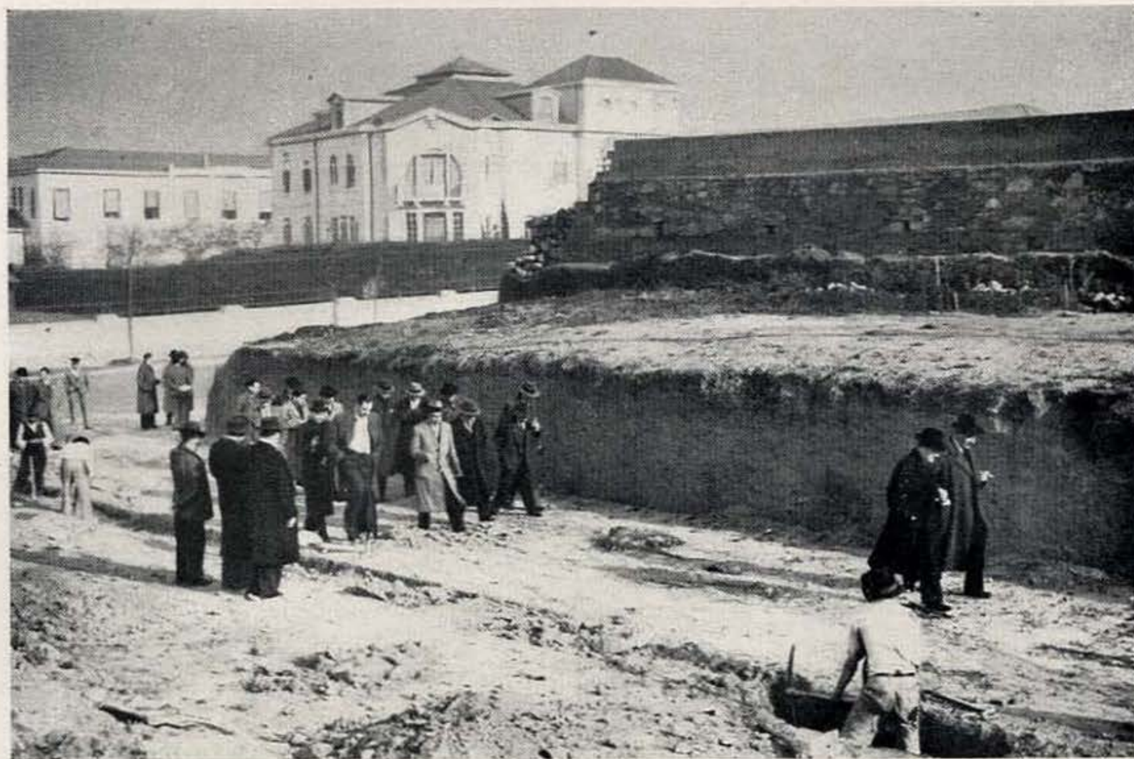
O Presidente e a vereação da C. M. L. visitando as obras de urbanização da zona a sul da Avenida Alferes Malheiro
