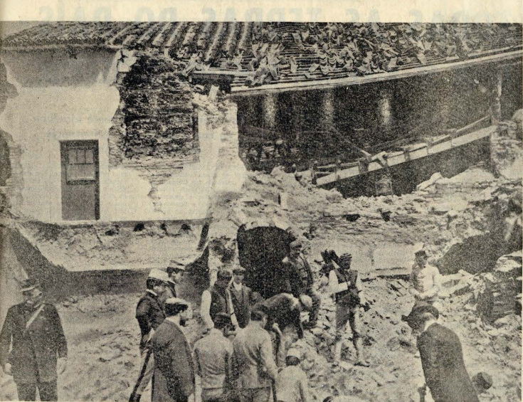
Um dos terramotos que, embora circunscrito a zona restrita, mais prejuízos causou em haveres e vidas, foi o de Benavente, ocorrido a 23 de Abril de 1909 — povoação que fora destruída em 1531, e que ficou também muito danificada com o tremor de terra de ano de 1755. A fotografia mostra um pormenor da jornada pedrosa à procura dos corpos das vítimas
