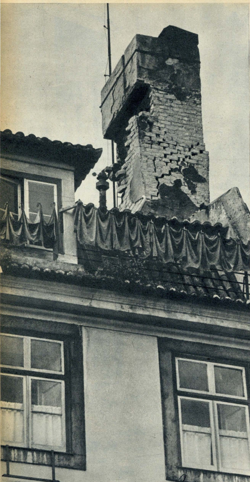
Os efeitos do abalo telúrico fizeram-se sentir principalmente nas chaminés e empenas dos prédios. Foram muitas as que os bombeiros tiveram de apelar por constituírem perigo.
