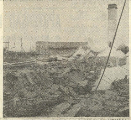
FIGOU REDUZIDA A ESCOMBROS UMA FÁBRICA DE CERÂMICA DE PINHAL NOVO
