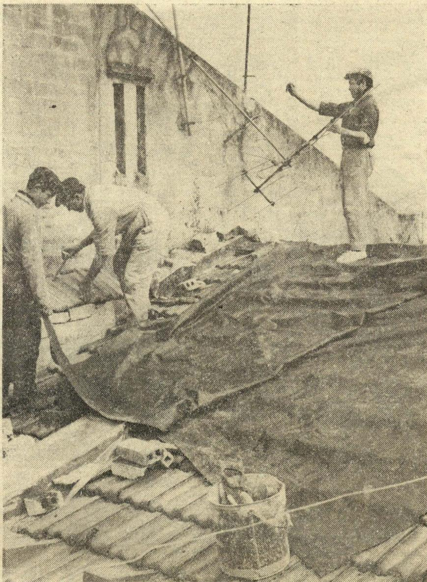
Chegou a hora das reparações: operários da construção civil colocam uma lona a tapar um rombo aberto num telhado por uma chaminé que se desmoronou
