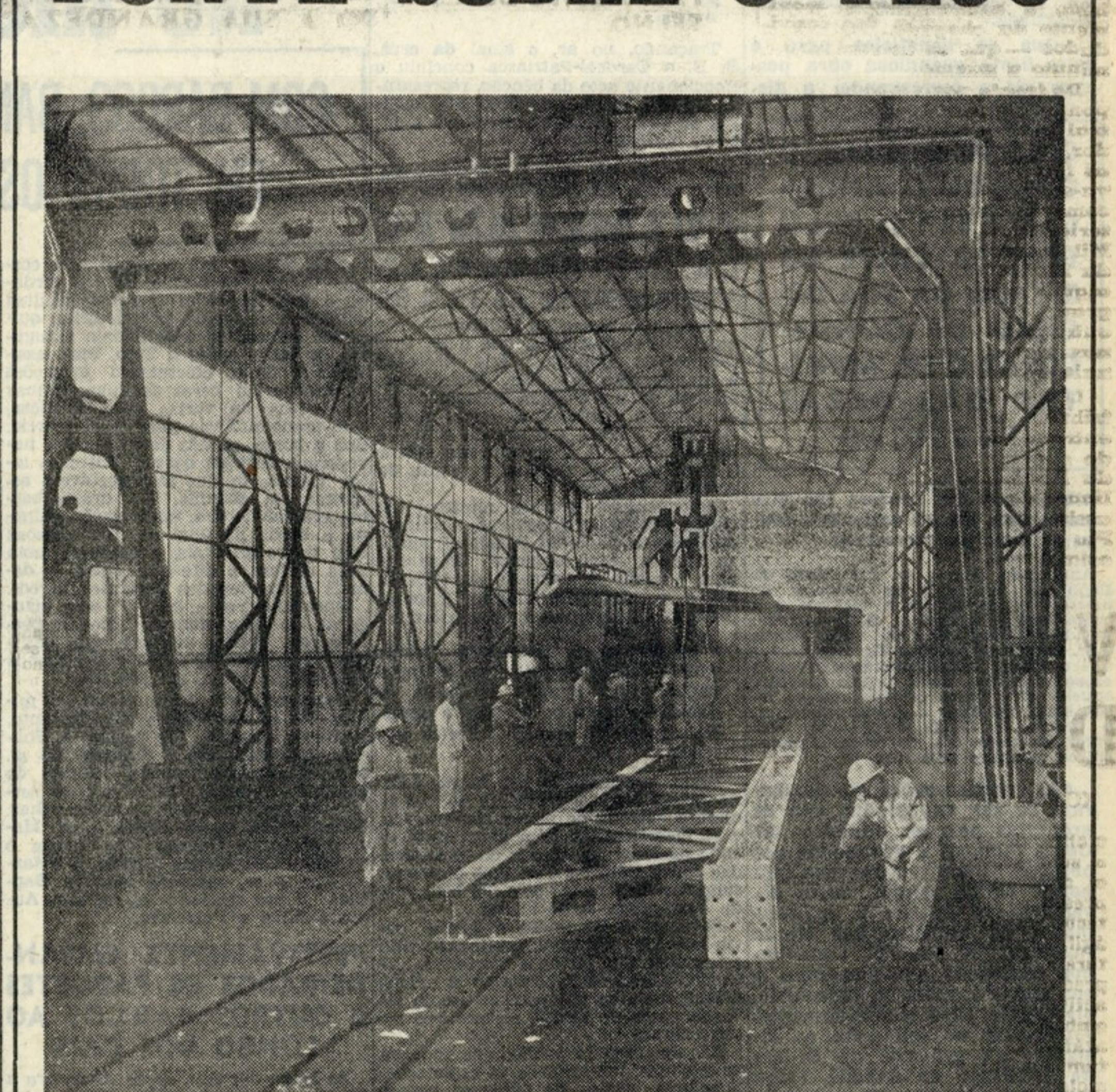
VISTA PARCIAL DO ESTALEIRO
