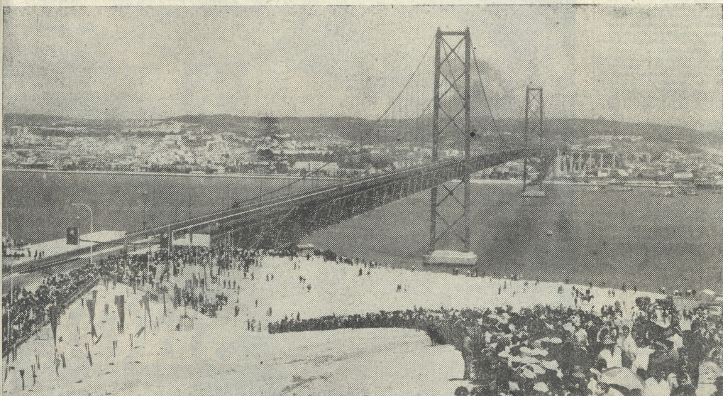
Vista do lado sul, a ponte oferecia ontem esta perspectiva aos milhares de pessoas que se encontravam perto do monumento a Cristo-Rei
