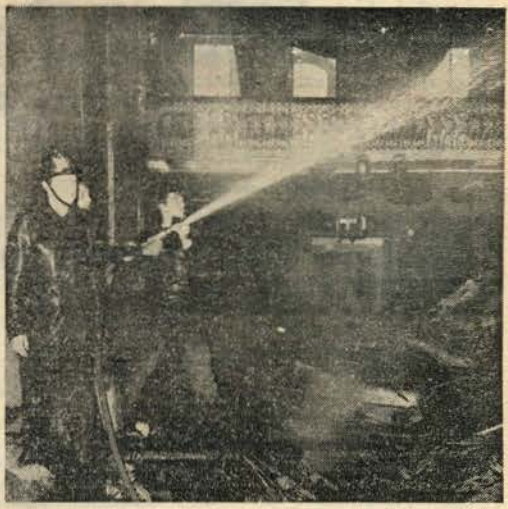
Um aspecto do combate ao incêndio, no Interior do Teatro quando o tecto ainda não tinha abatido
