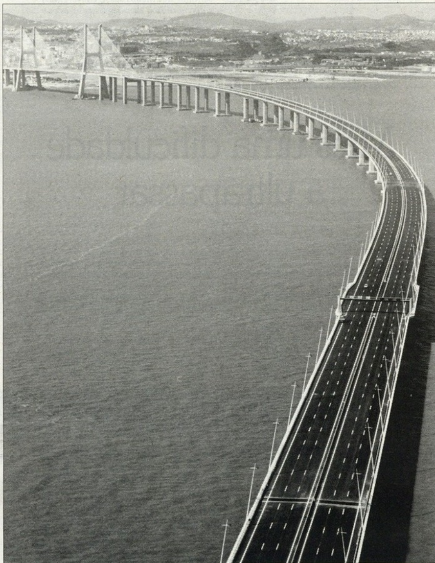
A morte de duas crianças marcou a construção da Ponte Vasco da Gama e os engenheiros foram ontem absolvidos
