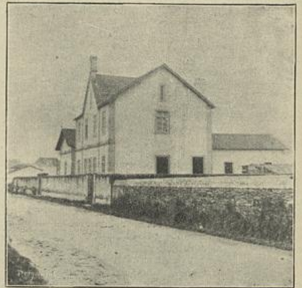
CASA DA ESCOLA RODRIGUES SAMPAIO EM ESPOSENDE
