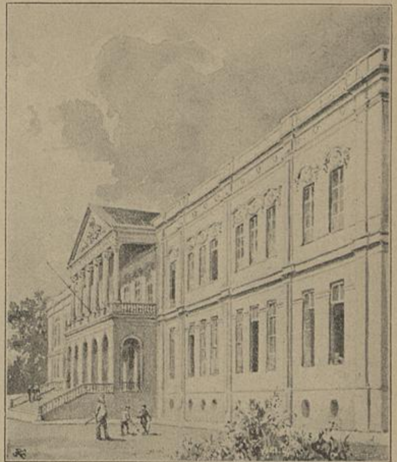
INSTITUTO «LAURO SODRÉ» — FACHADA PRINCIPAL
