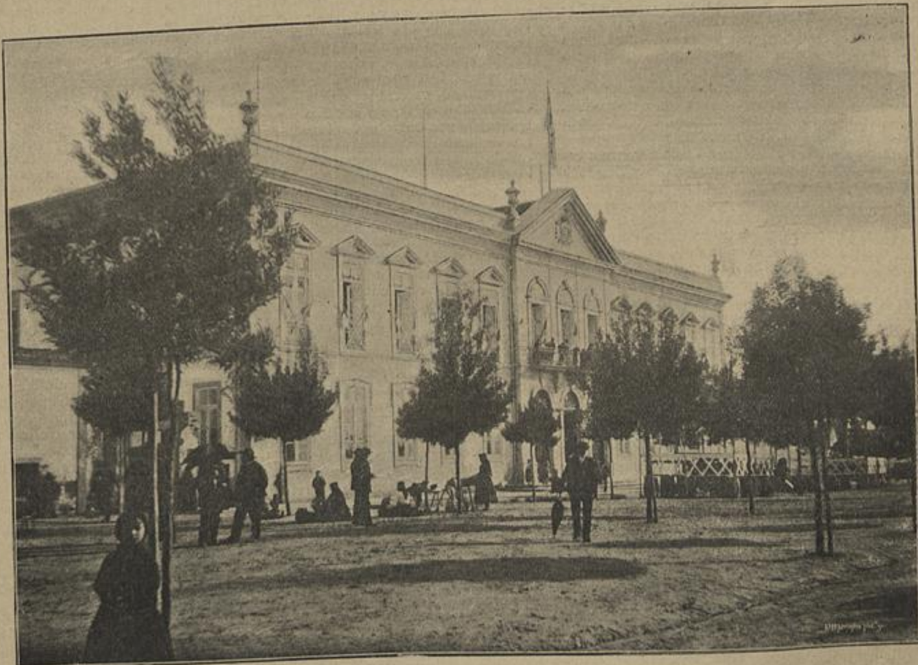
NOVO EDIFICIO DOS PAÇOS DO CONCELHO DE ESTARREJA
