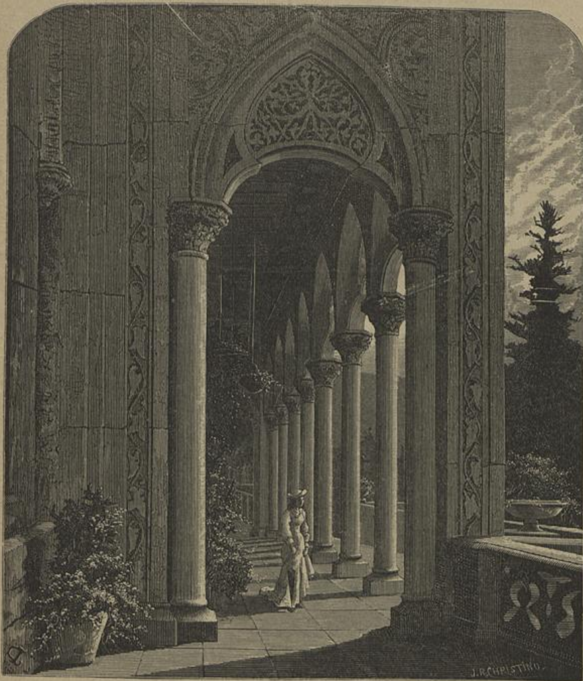
MONSERRATE — VISTA DA GALERIA EXTERIOR
