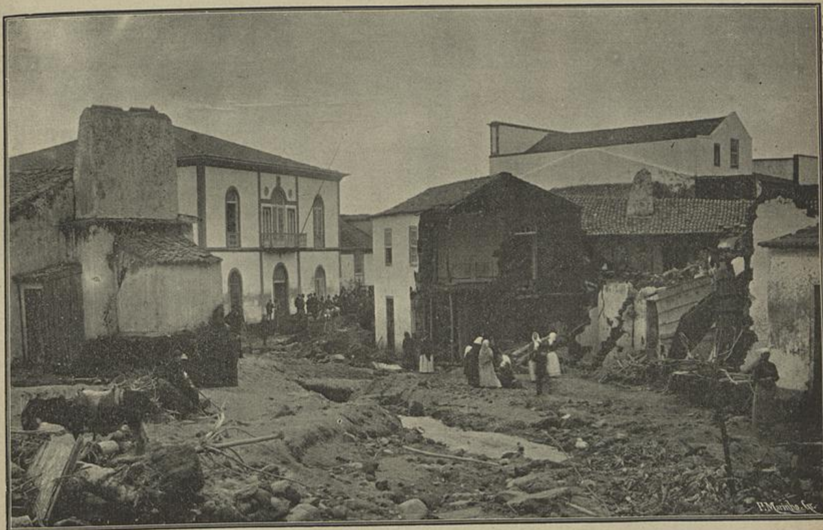
AS INUNDAÇÕES NA VILLA DA POVOAÇÃO — ASPECTO DAS RUINAS
