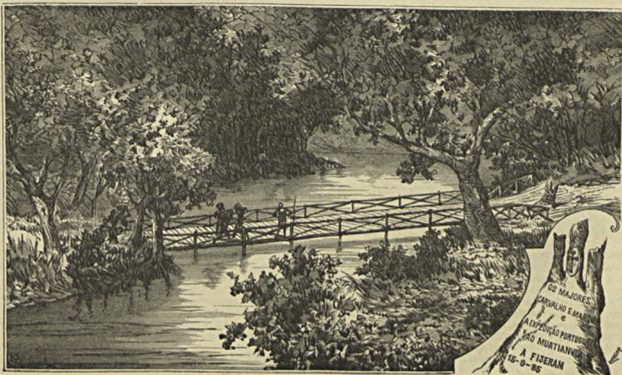
PONTE DO CUANGO, CONSTRUIDA PELA EXPEDIÇÃO
