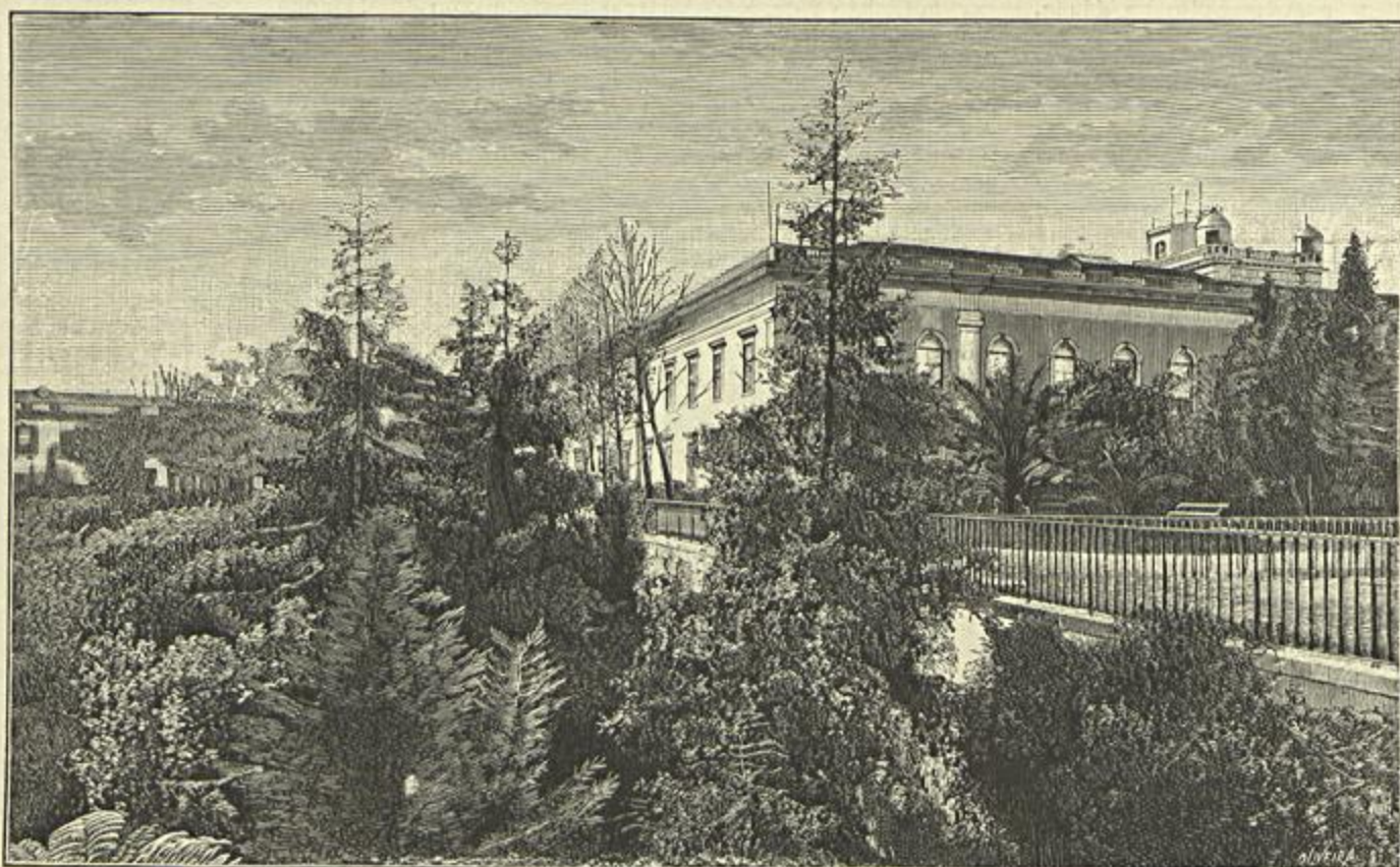
EDIFICIO DA ESCOLA POLYTECHNICA — VISTO DO JARDIM
