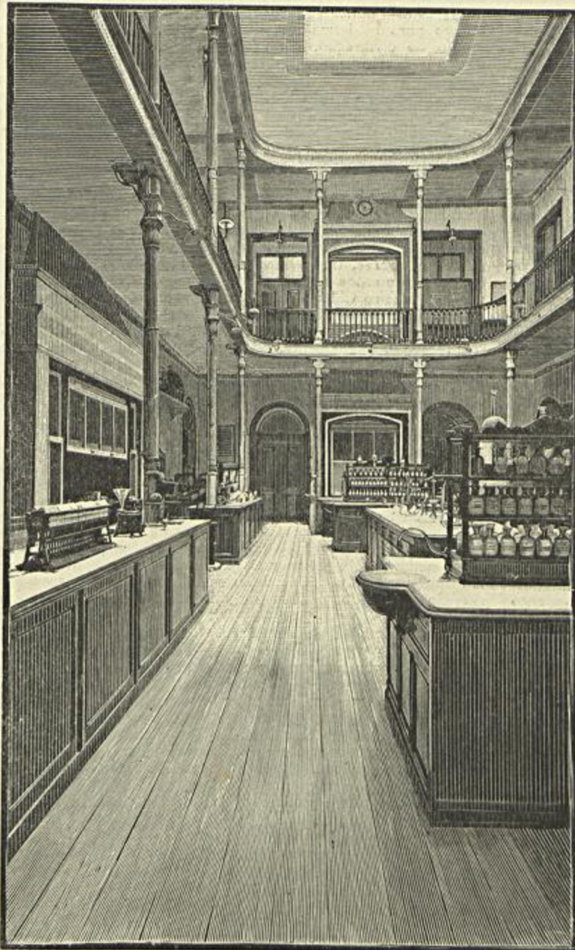
LABORATORIO DE CHIMICA MINERAL DA ESCOLA POLYTECHNICA'— VISTO DA GALERIA
