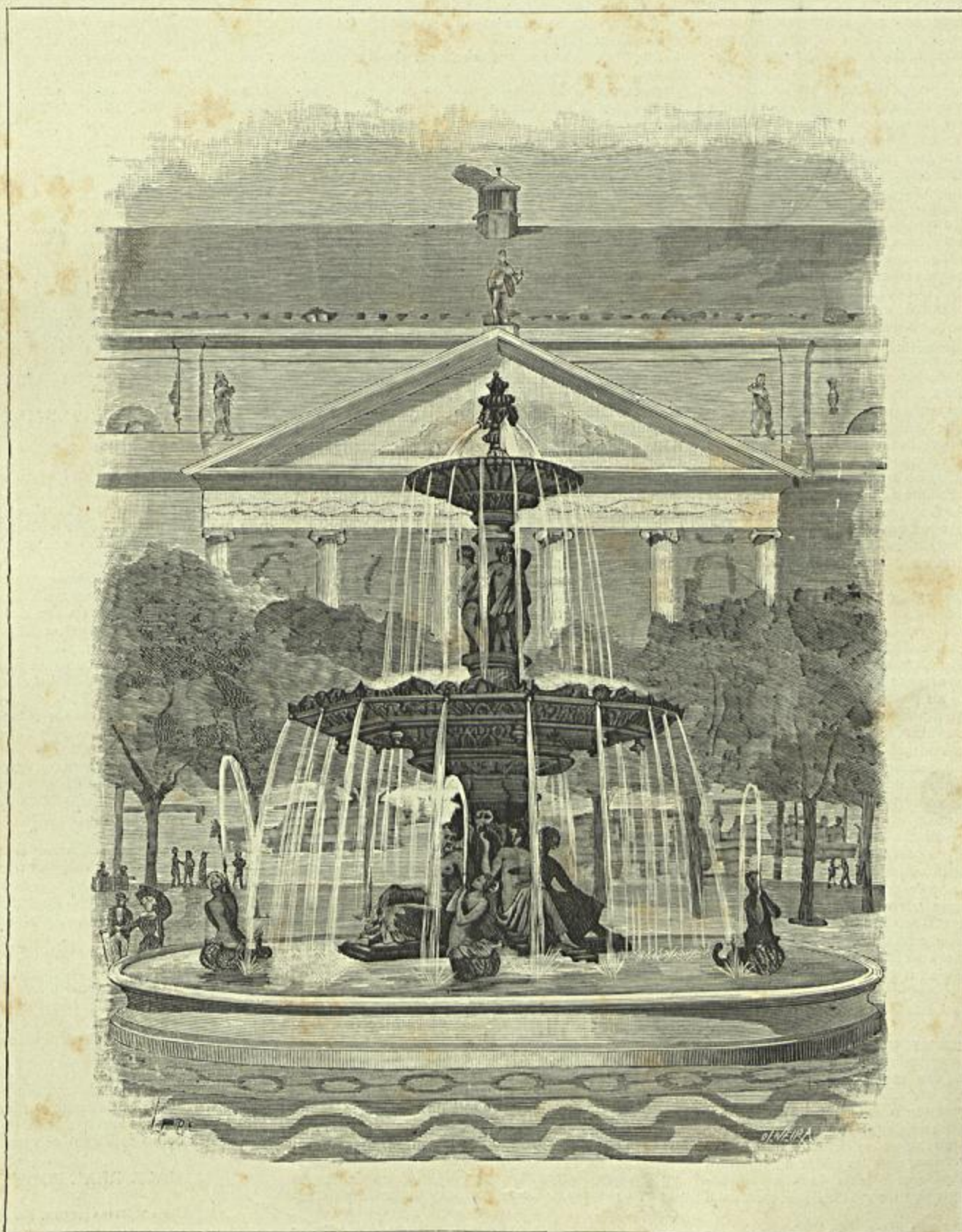
MELHORAMENTOS DE LISBOA—FONTE MONUMENTAL EM CONSTRUÇÃO NO ROCIO (Desenho de L. Freire)
