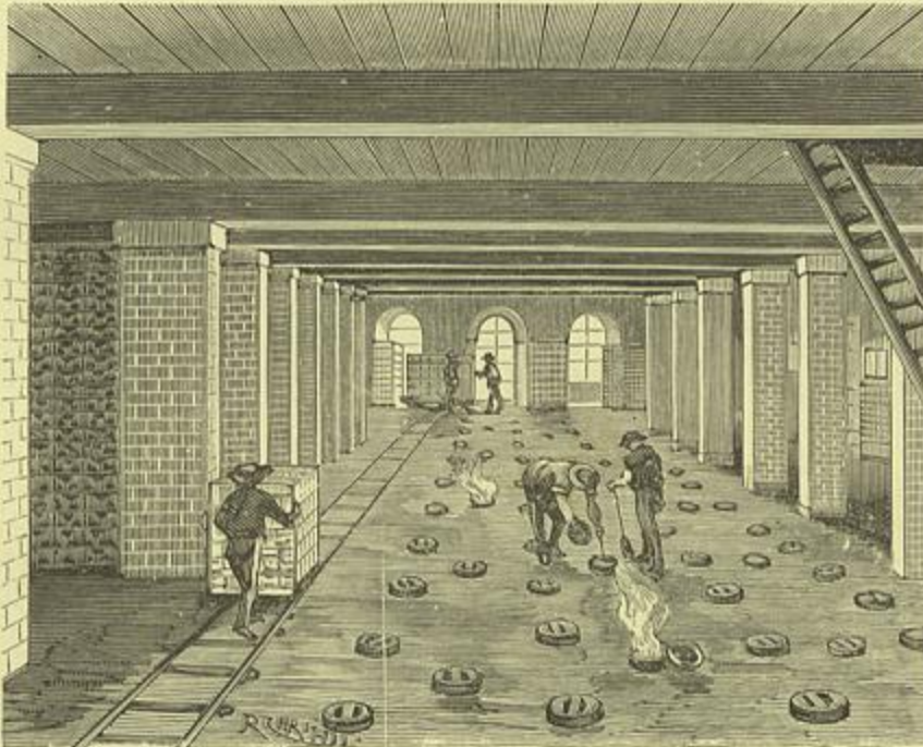
PAVIMENTO SUPERIOR DO FORNO E ENXUGADOUROS
