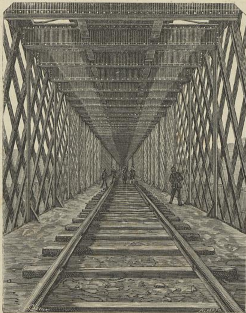
PONTE INTERNACIONAL SOBRE O MINHO — TÁBOLEIRO INFERIOR (Segundo uma photographia da casa Biel & C. a , do Porto)
