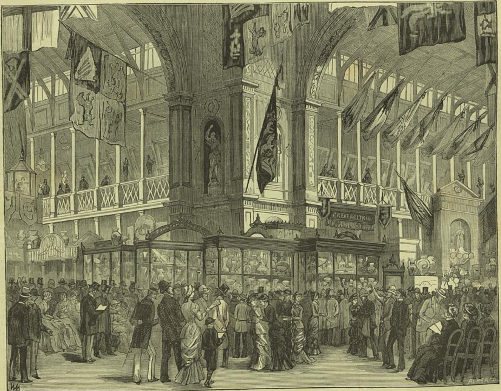
AUSTRALIA — EXPOSIÇÃO DE MELBOURNE, VISTA INTERIOR DO PALACIO
