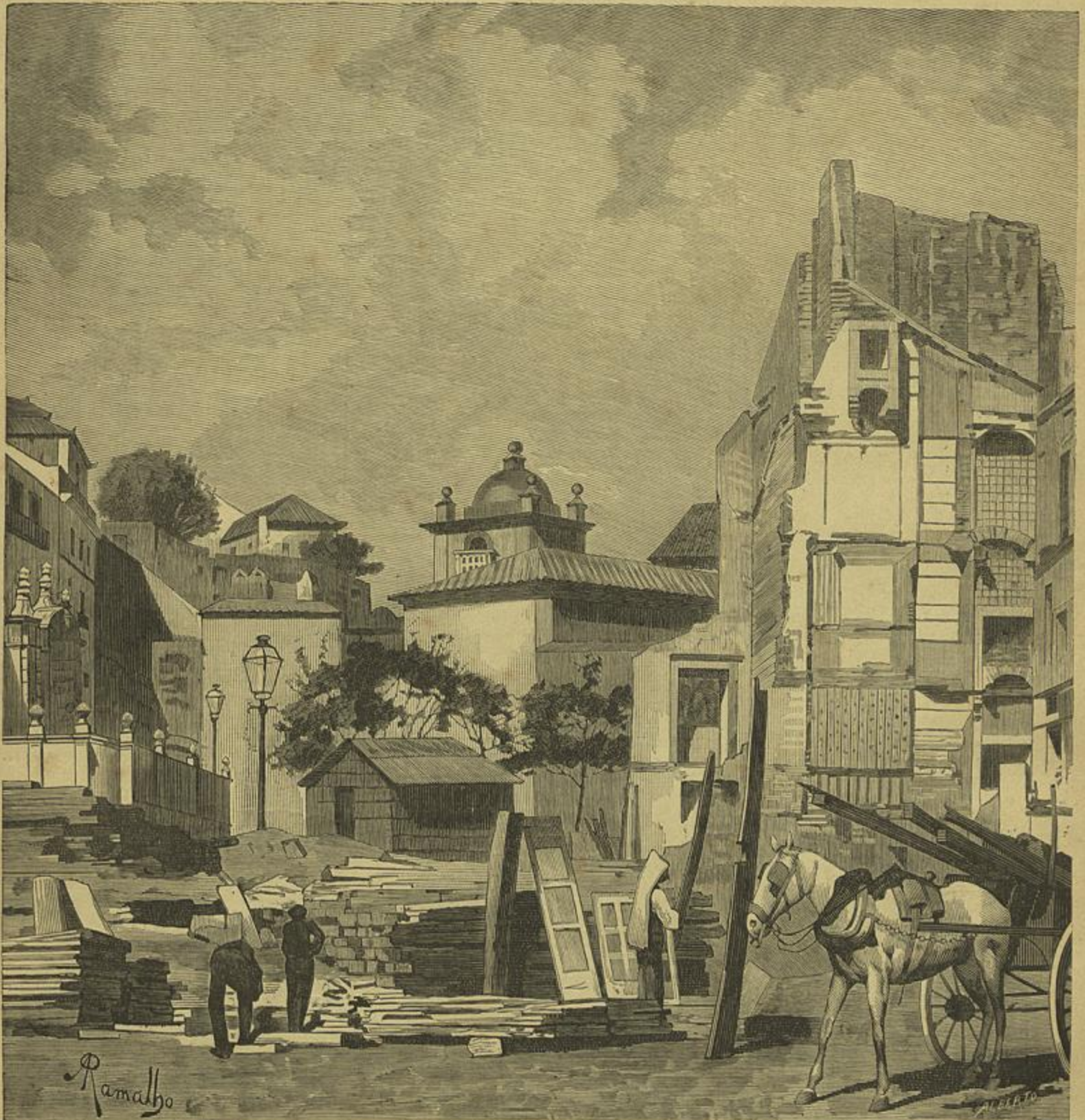
MELHORAMENTOS DE LISBOA — RUA DO DUQUE DA TERCEIRA — DEMOLIÇÕES NO LARGO DA ESPERANÇA
