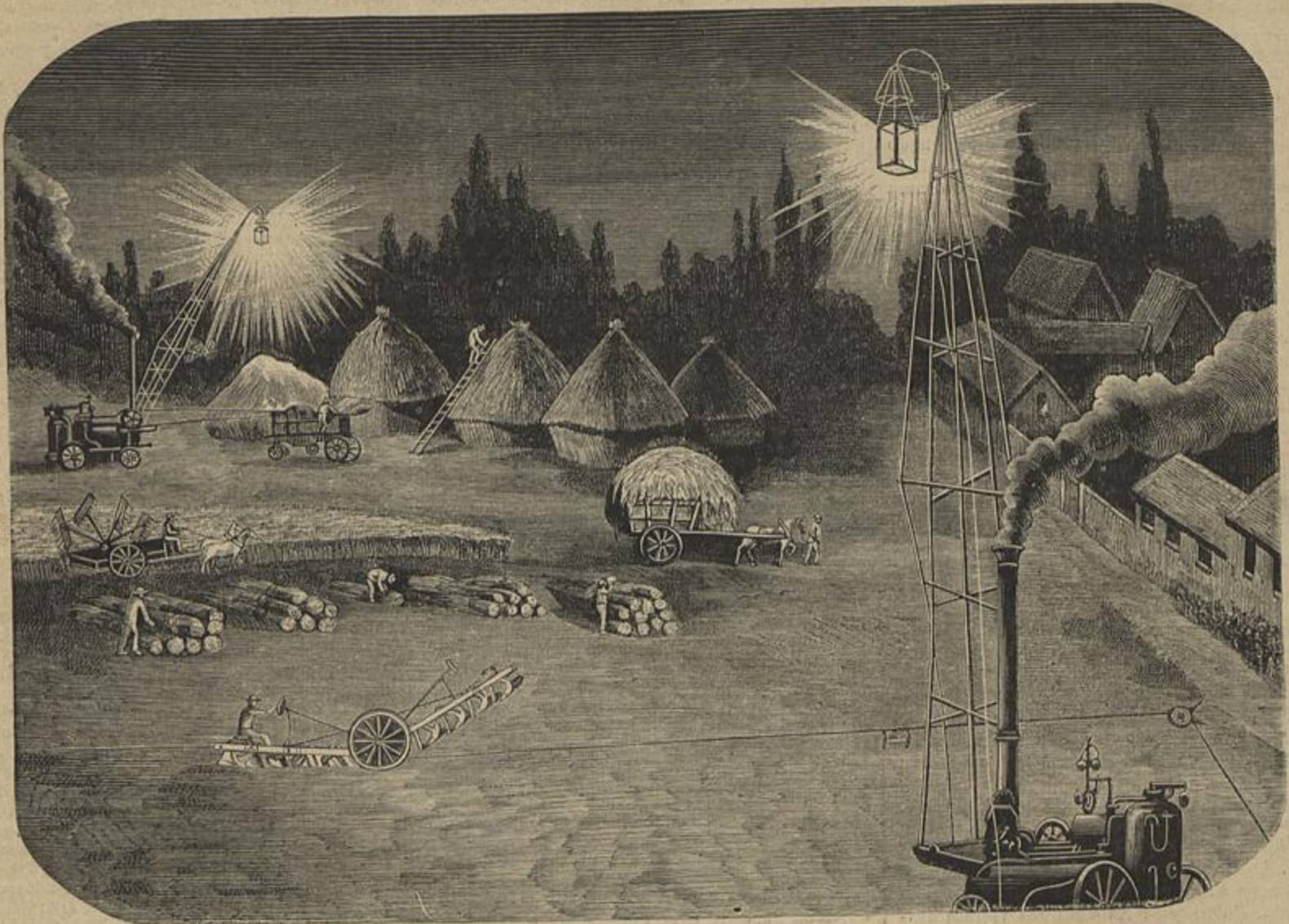
TRABALHOS RURAES Á LUZ ELECTRICA
