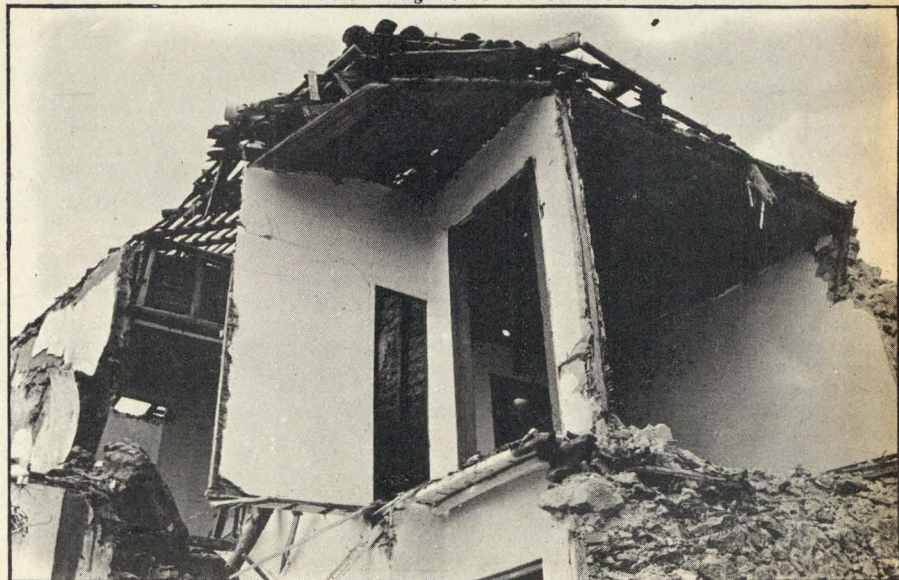
Barão de São Miguel. De uma só rua. 30 ou mais casas derrubadas?
