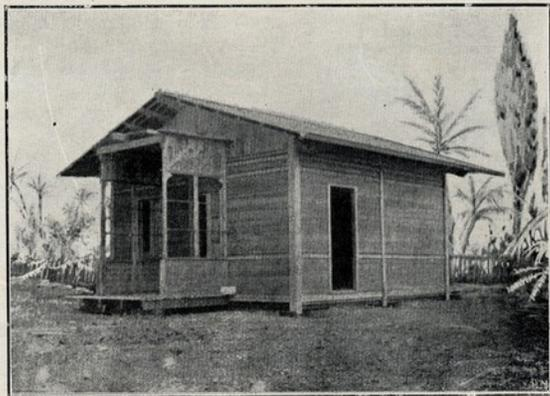
5 de largo e outros tantos de altura. Póde montar-se sobre tijolos e, querendo, fóra do solo para maior facilidade do seu transporte. O telhado é de papelão-pedra sobre madeira e o seu peso total é de 5:200 kilos, incluindo os tabiques desmontaveis que facultam fazer o numero de divisões interiores conforme as conveniencias de momento.
