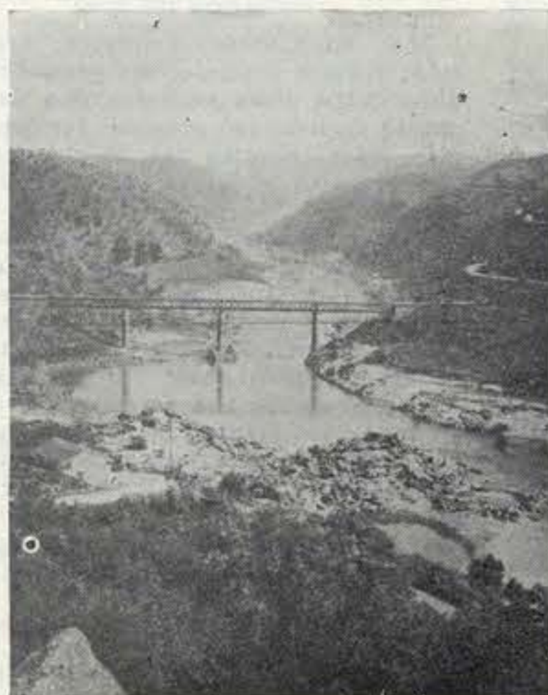
Ponte sobre o Tejo (Gavião)
