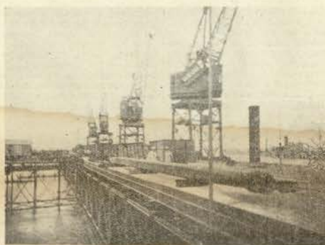
Moçambique — Beira — Ponte Cats
