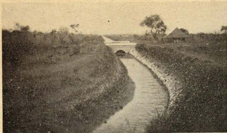
Obras de rega do canal de Inhamita, efectuadas pela Companhia Colonial do Buzi
