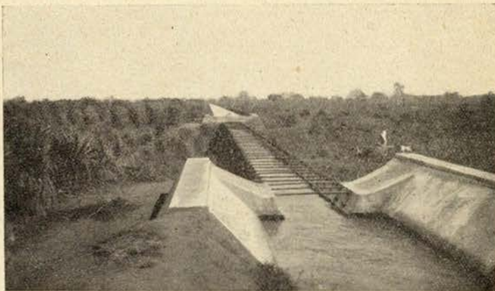
Obras de rega — Canal de 3.000 litros por segundo construído pela Companhia Colonial do Buzi
