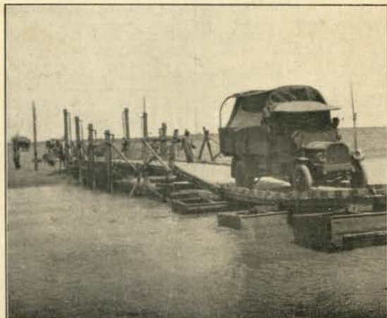
Automoveis militares de transporte atravessando uma ponte
