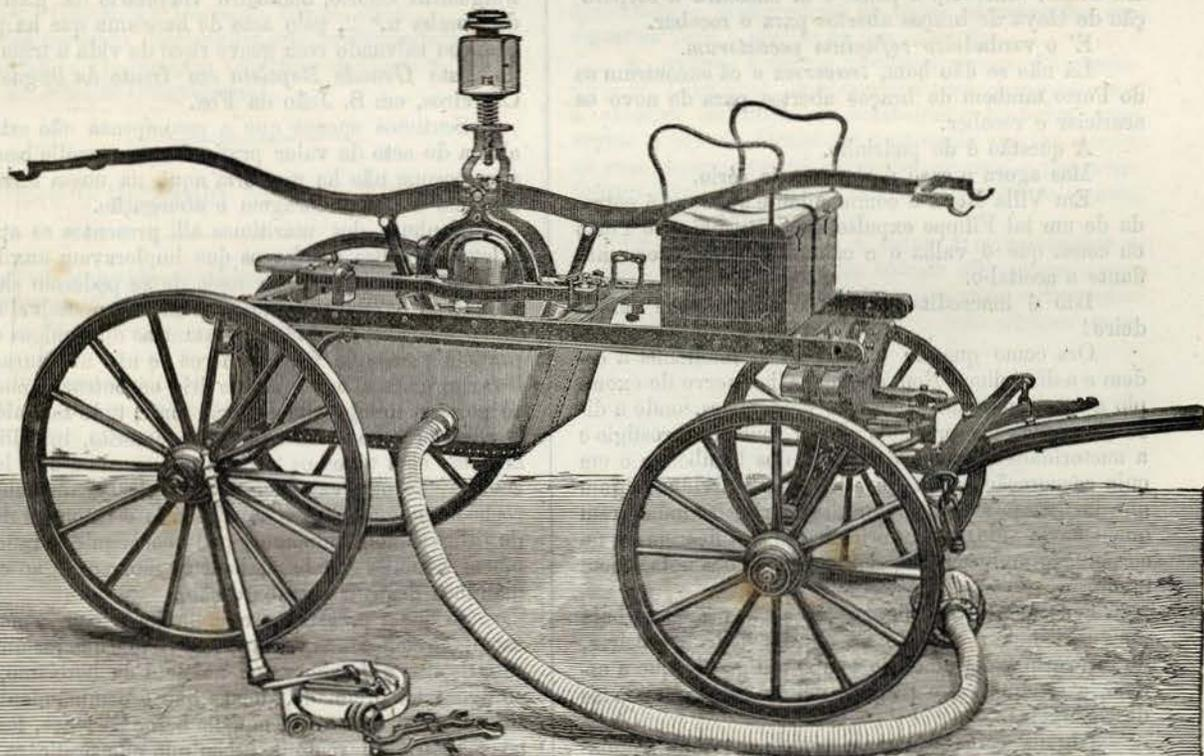
transitar com rapidez e segurança por mans caminhos, visto ser especialmente destinada para o campo. Trabalha sem ser necessario desmontal-a da rodagem, e tanto pôde ser alimentada com agua lançada no inte-
