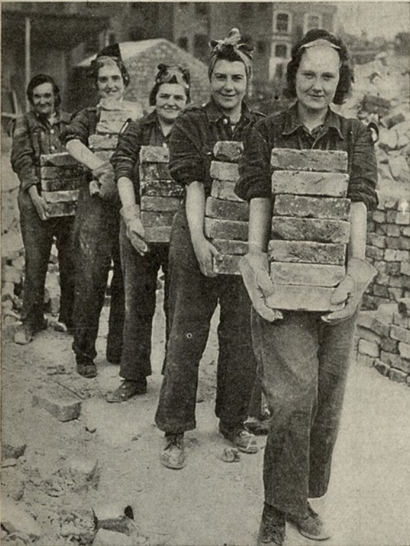
A reconstrução da capital do Império prossegue intensivamente. As mulheres fazem, alegremente, serviço de pedreiro. Estas transportam tijolos para um prédio que se está construindo num tempo «récord». Uma nova Londres nasceu depois do «blitz».
