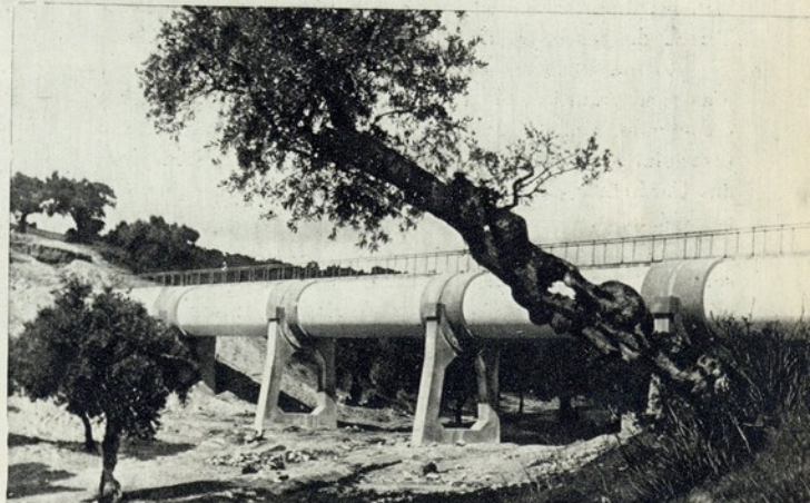
Lisboa já tem água à vontade. Eis um «pipeline» recentemente construído
