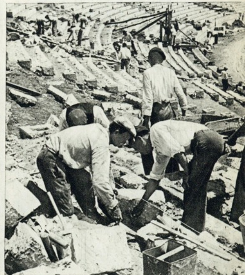
A construção do Estádio Nacional deu trabalho e alegria a muitos operários
