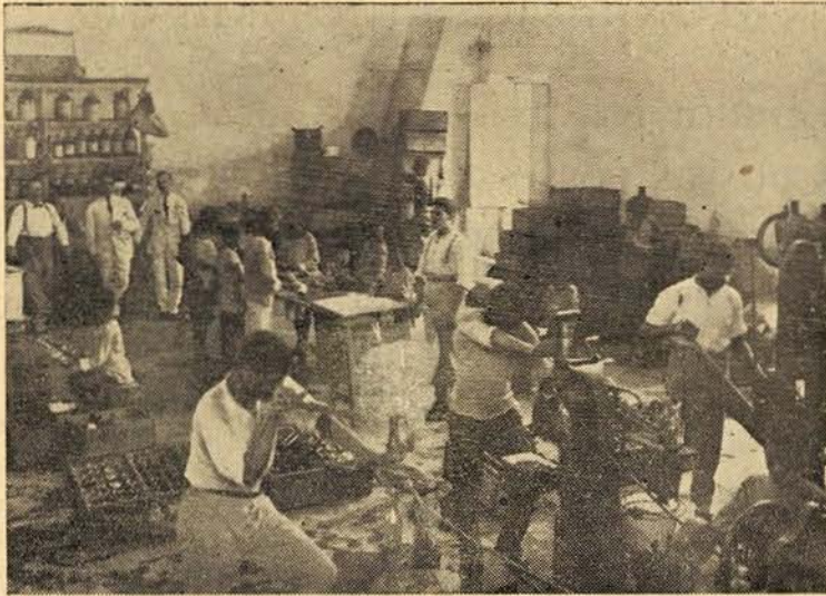
Engarraamento e secção de fabricação de pirlitos.
