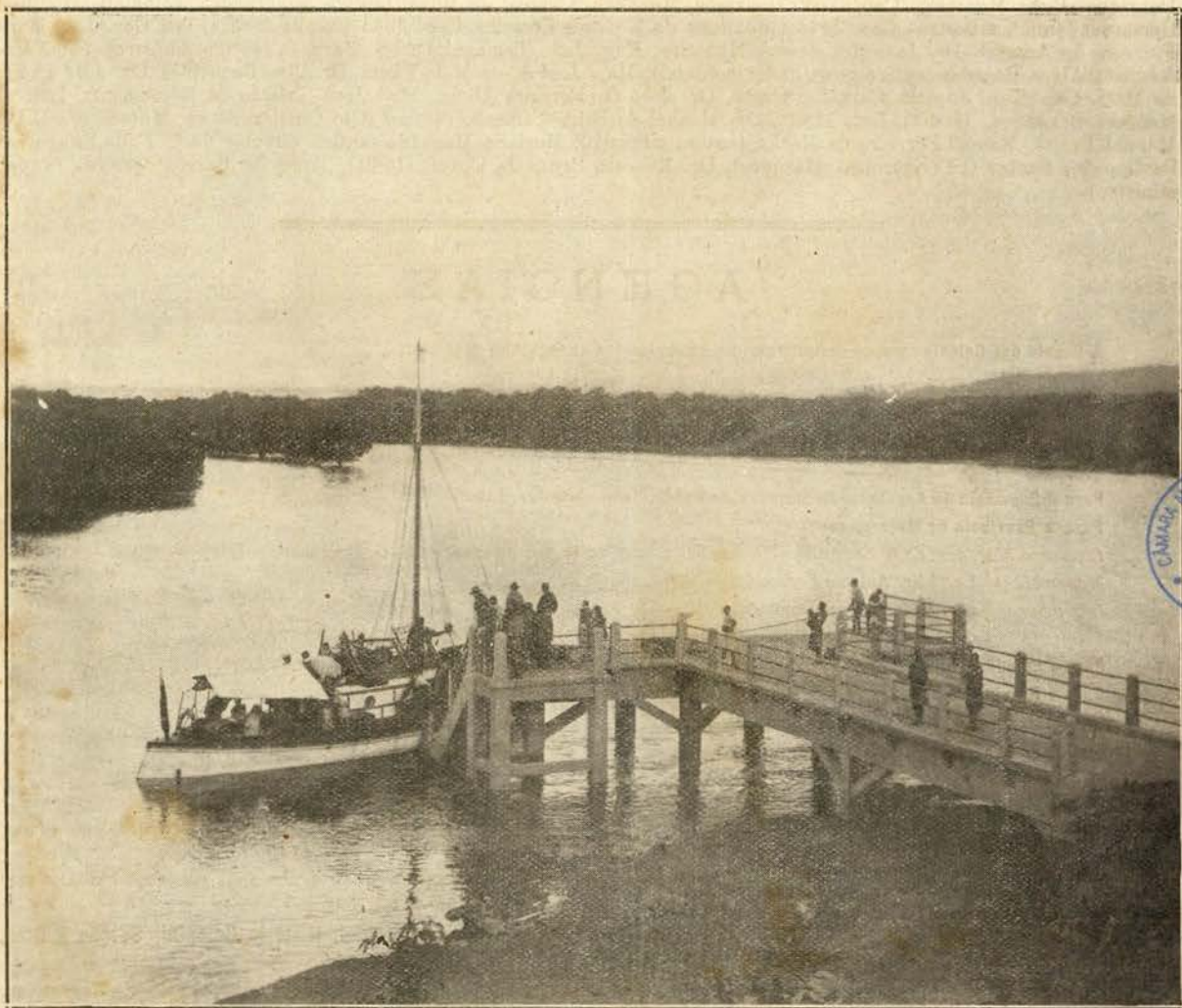
MOÇAMBIQUE — Ponte-cais de Morrumbene (Distrito de Inhambane) Atracção do gazolina das carreiras regulares Inhambane-Morrumbene.
