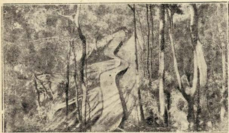
Uma das valas de captação das aguas pluvias na colina da Guia
