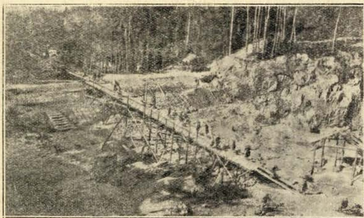
Construção de uma Represa da captação de aguas pluviais, com a capacidade de 14.500 metros cubicos
