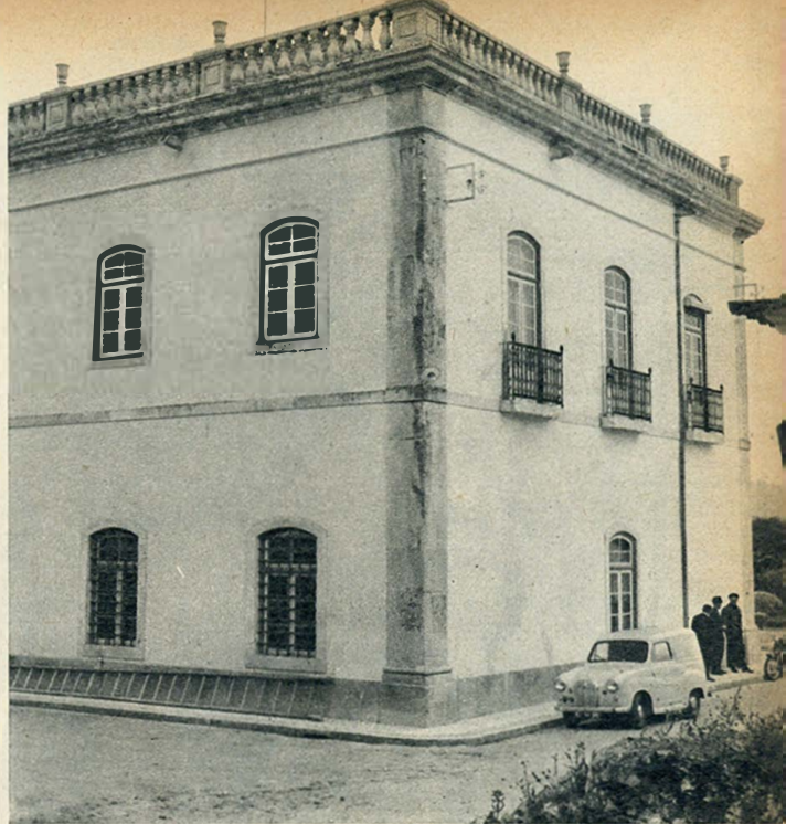
Vila Nova de Ourém. Este é o edifício dos Paços do Concelho, antiga administração do concelho e cadeia municipal. Na imagem vêm-te duas janelas gradeadas correspondentes à prisão, onde os pastores estiveram detidos, sob a ameaça de serem queimados em azeite a ferver, se não dissessem o «segredo» que a Senhora lhes revelara. Mas eles nada revelaram e o administrador, vencido, foi colocá-los em Fátima, no dia seguinte.
