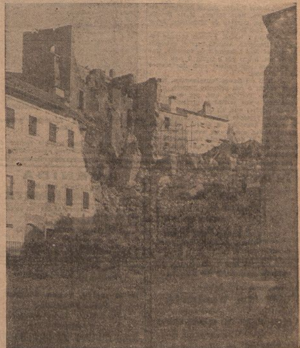
Um aspecto impressionante da derrocada
