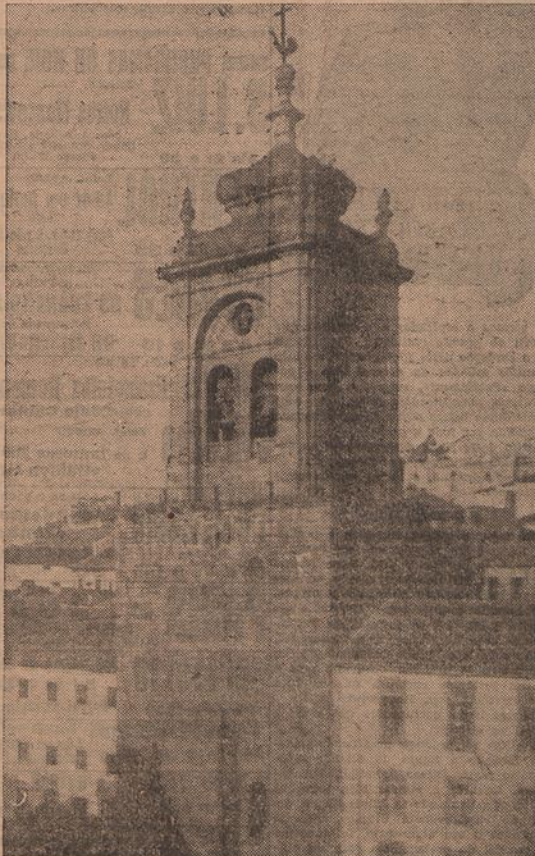
A torre da Santa Cruz, antes da derrocada
