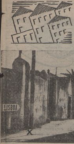
Os sinais X marcam a extensão das demolições que vão fazer-se em Santarém para acabar com a esgarantada à entrada da capital ribatejana
