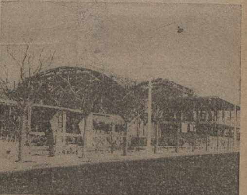
O estado actual da construção das instalações do Pavilhão das Indústrias
