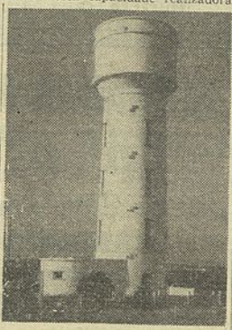
Reservatório de água de Sarilhos Grandes
