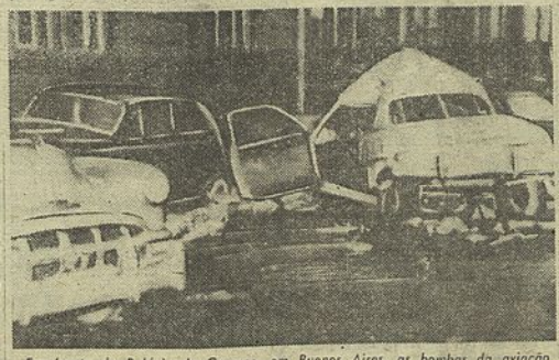
Em frente do Palácio do Governo, em Buenos Aires, as bombas da aviação, rebelde causaram elevado numero de victimas, destruindo varios automóveis, que ali estacionavam
