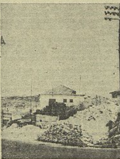
A gravura mostra os trabalhos preliminares da construção de grande moradia na rua D. Francisco de Almeida, no Bairro do Restelo. Ao proceder-se à abertura das fundações, surgiu uma pedra, de enorme capacidade, que o construtor aproveitou com larga vantagem financeira. Mas, se a este foi benéfico o achado, sobrevieram paralelamente um perigo e um tormento para os moradores vizinhos. Além do constante e incomodativo estrondo dos martelos de pólvora, vieram os perigos de destruição e (quem sabe?) de morte. Em todas as direcções são projectadas pedras, que partem vitrosas e incandescentes, atravessam jardins. Mas (o que ainda é pior), que pode acontecer a quem tranquilamente assume a uma janela ou se atreva a entrar ou a sair de uma porta no preciso momento de uma dessas explosões? Ninguém o sabe, mas avalia-se. Se é certo que a obra tem de prosseguir, não menos certo é que devem tomar-se medidas que eliminem o perigo e preservem a vida. E tais medidas parece não serem difíceis com um pequeno estudo do caso. A obra vai em meio, havendo, portanto, muito a esperar quanto a perigos sanitários. A Praça de Dom João, que fica próxima, oferece identicos riscos e, por muito frequentada por crianças, mais incita ainda à resolução que se impõe.
